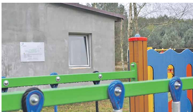
„Razem damy radę, modernizacja budynku w Ryszczewie”
